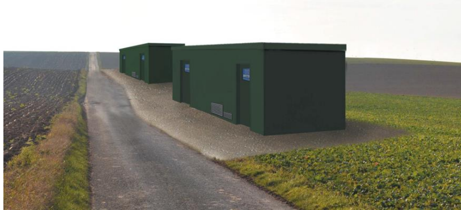
Figure 6 : Illustration du poste de livraison du parc éolien de la Vallée d'Élincourt (source : Laurent Couâsnon, 2016)
